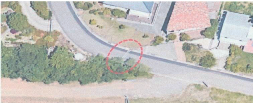
この横断側溝は開発記録簿に記載がない。 このことから④宅地造成の流末排水の一部を熱海市が改修している。
